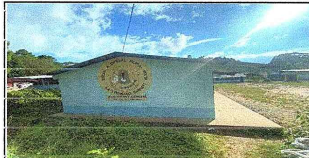
FINALIZACION DE PINTURA DEL ESTABLECIMIENTO
