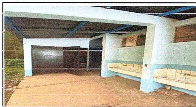
ACABADO DEL TRABAJO DE BAÑOS
